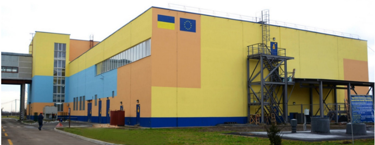
Будівля КПРАВ РАЕС
