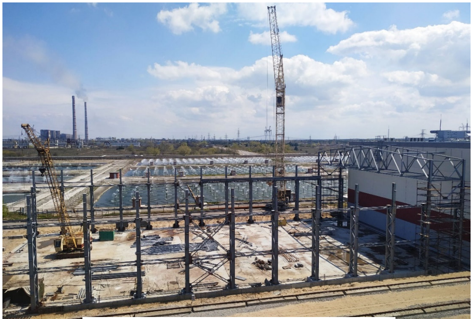
Будівництво сховища легкого типу
